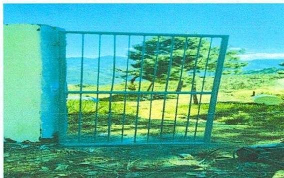
Foto 2: MANTENIMIENTO DE PORTON DE ESCUELA
